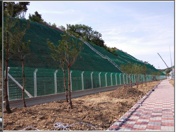
② 절토사면 시공 현황(중점 횡단)
