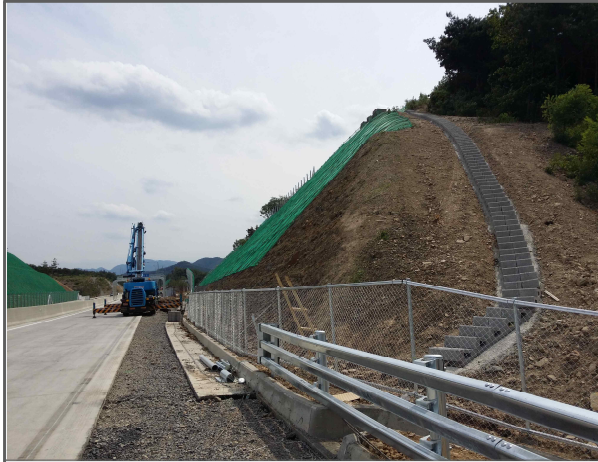
① 절토사면 시공 현황(시점 횡단)
